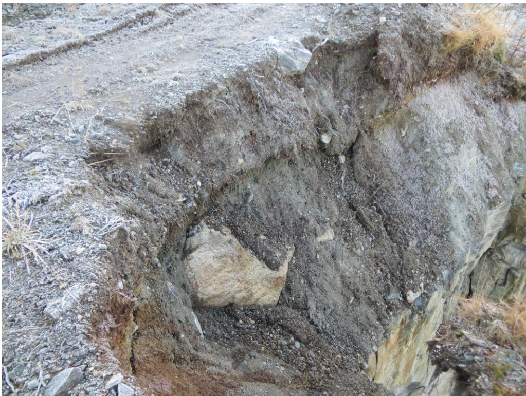
Figur 21 Fra skjæring i sørlige del av tomten, figur 20, som viser fjell med tynt lag av strandsedimenter og tynt overliggende humuslag. Punkt A figur 12 viser lokasjon.
