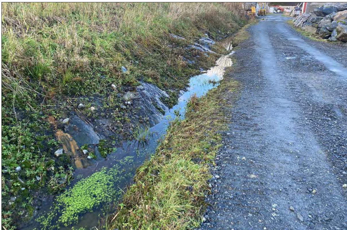
Figur 20: Fotopunkt 4 – fjell i dagen på oversiden av tilkomstveien, vest for den planlagte fyllingen. Foto: SGC.
