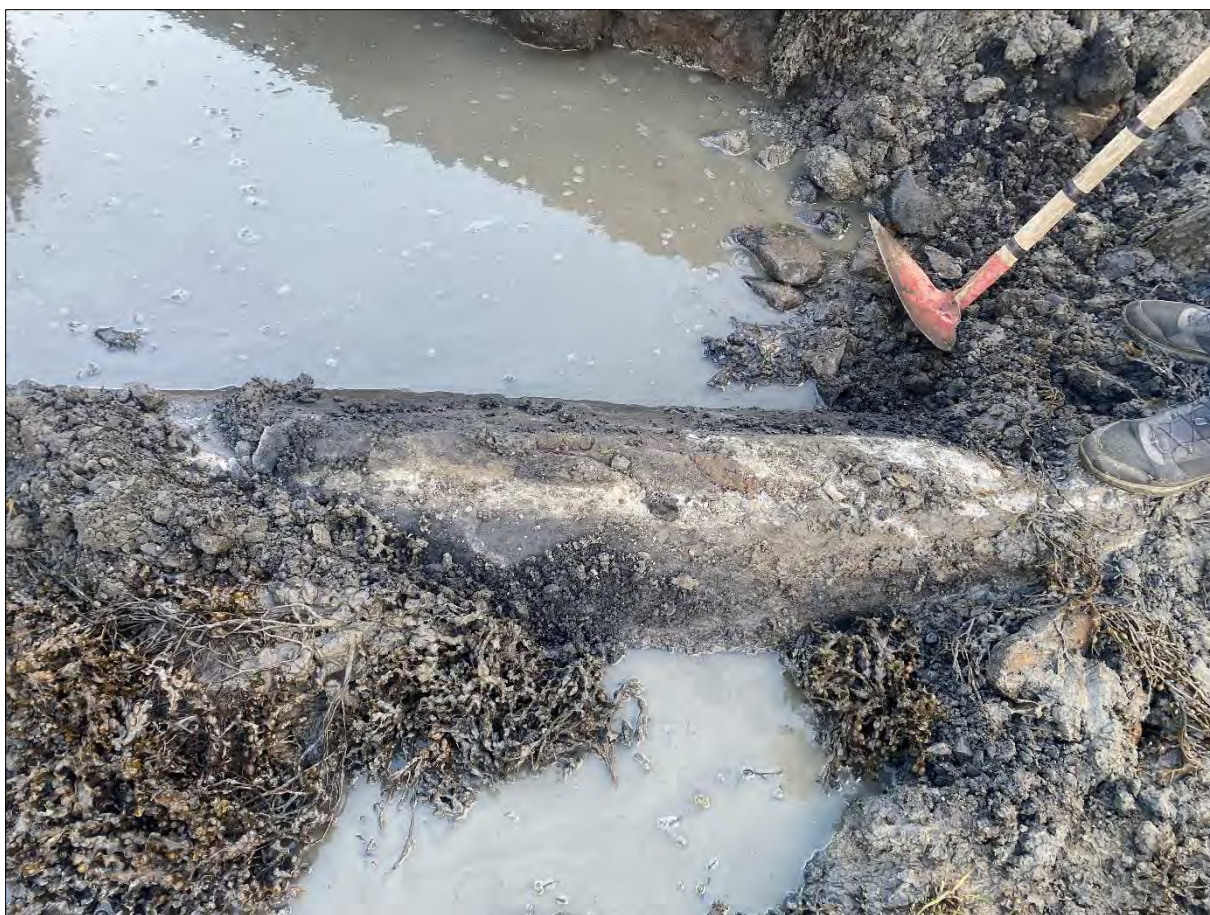
Figur 14: Foto av Gravepunkt 1 der det ble påvist fast fjell ved <0,5 m. Det skal ikke fylles lengre ut enn ved dette punktet. Foto: SGC.
