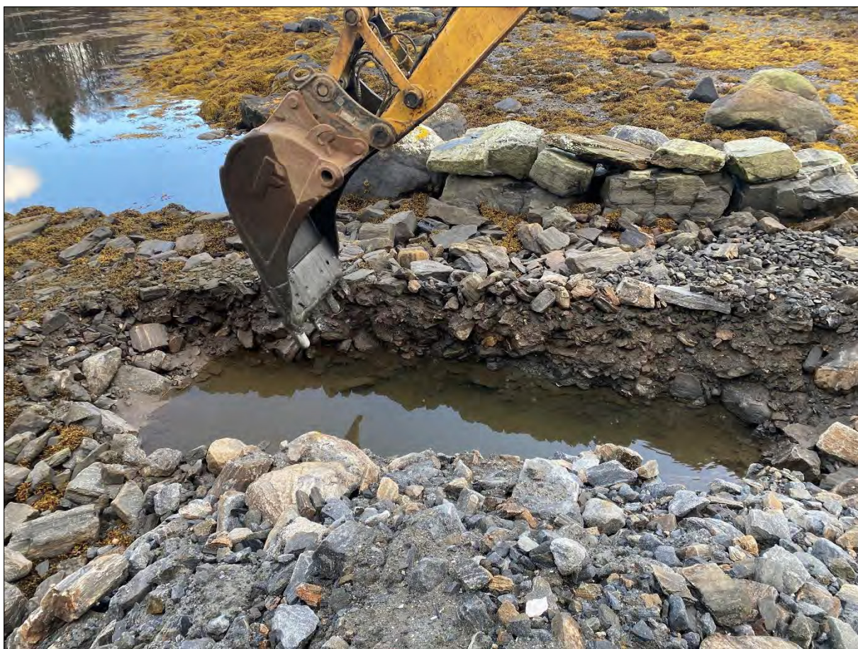
Figur 15: Gravepunkt 2 som er plassert i strandsonen sørvest for den eksisterende kaien. Her ble det ikke påvist fast fjell, men massene samsvarer med NGUs markering av strandavsetinger på løsmassekartet. Foto: SGC.
