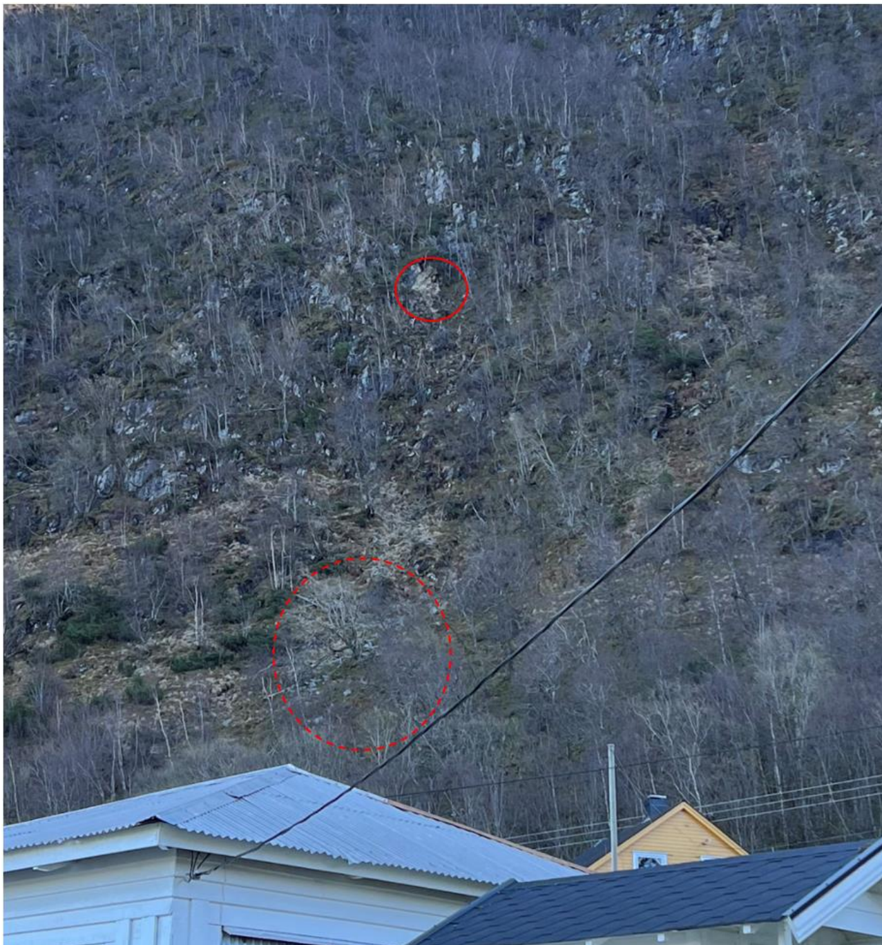
Figur 19. Nylig utfall av stein som har løsnet fra området markert med rød sirkel, og som har delt seg opp og stoppet i området markert med stiplet sirkel. I grensen til påvirkningsområdet
