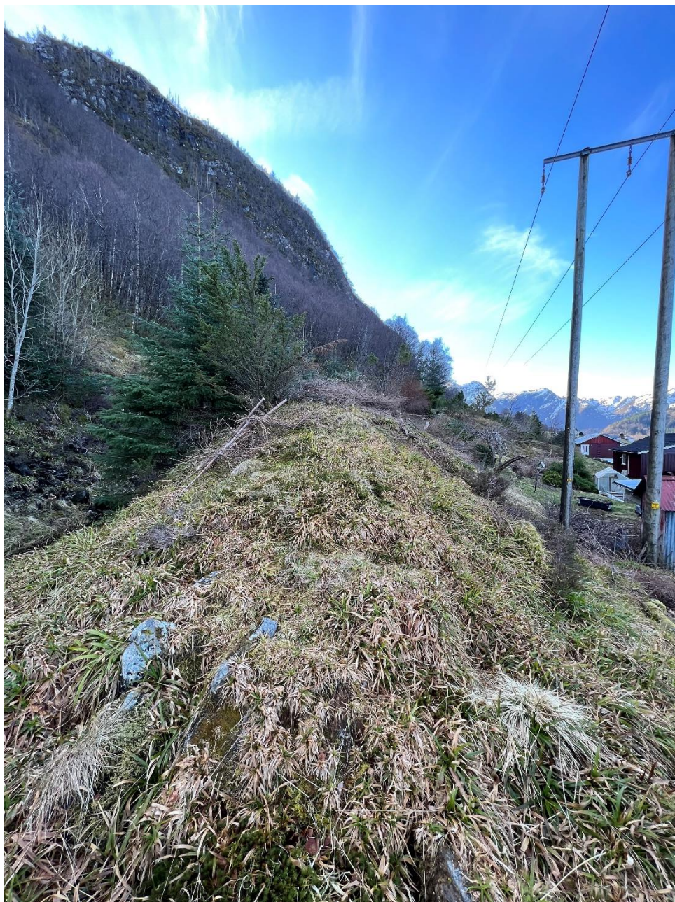
Figur 14. Steinsprangvullen ovenfor bebyggelsen gnr/bnr 72/15, 72/11 og 72/12.
