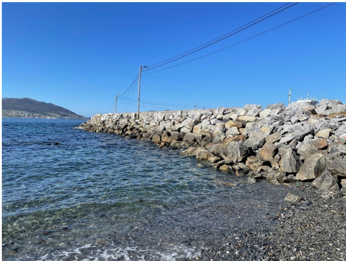
Figur 10 Foto 1 av moloens kortside ut fra land mot sjøen. Blokkene er lagt ut som en ordnet raus med et stort spekter av blokkstørrelser. Dekklaget later til å være intakt uten store skader.
