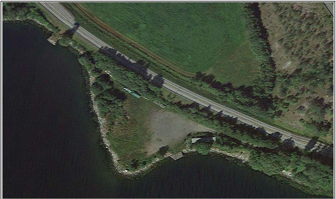
Utklipp frå Google earth, som viser m.a vegetasjonsstatus.
