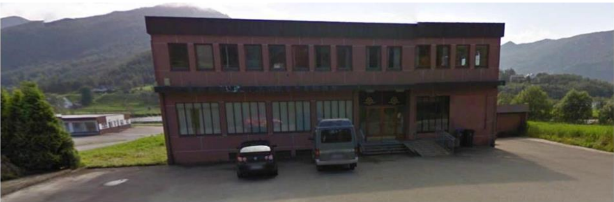
Figur 14: Gamle Sunnmørsbanken i utkanten av sentrumskjerna med to etasjer og flatt tak.
