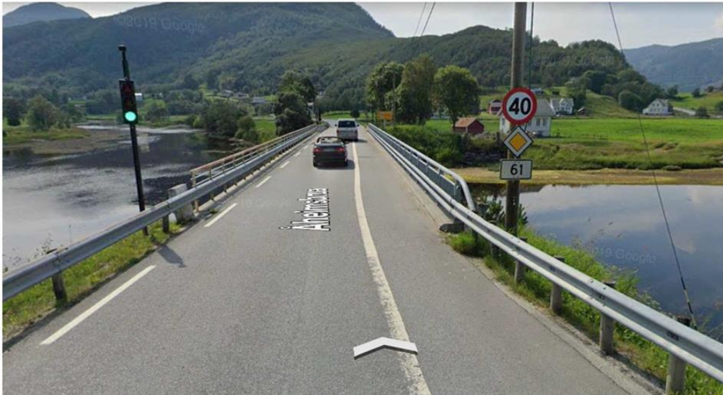
Figur 24: Brua over Åheimselva.
