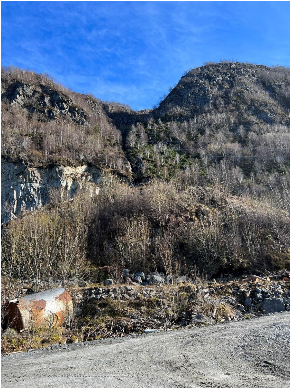
Figur 14. Renneformasjonen som kommer ned midt i steinbruddet.
