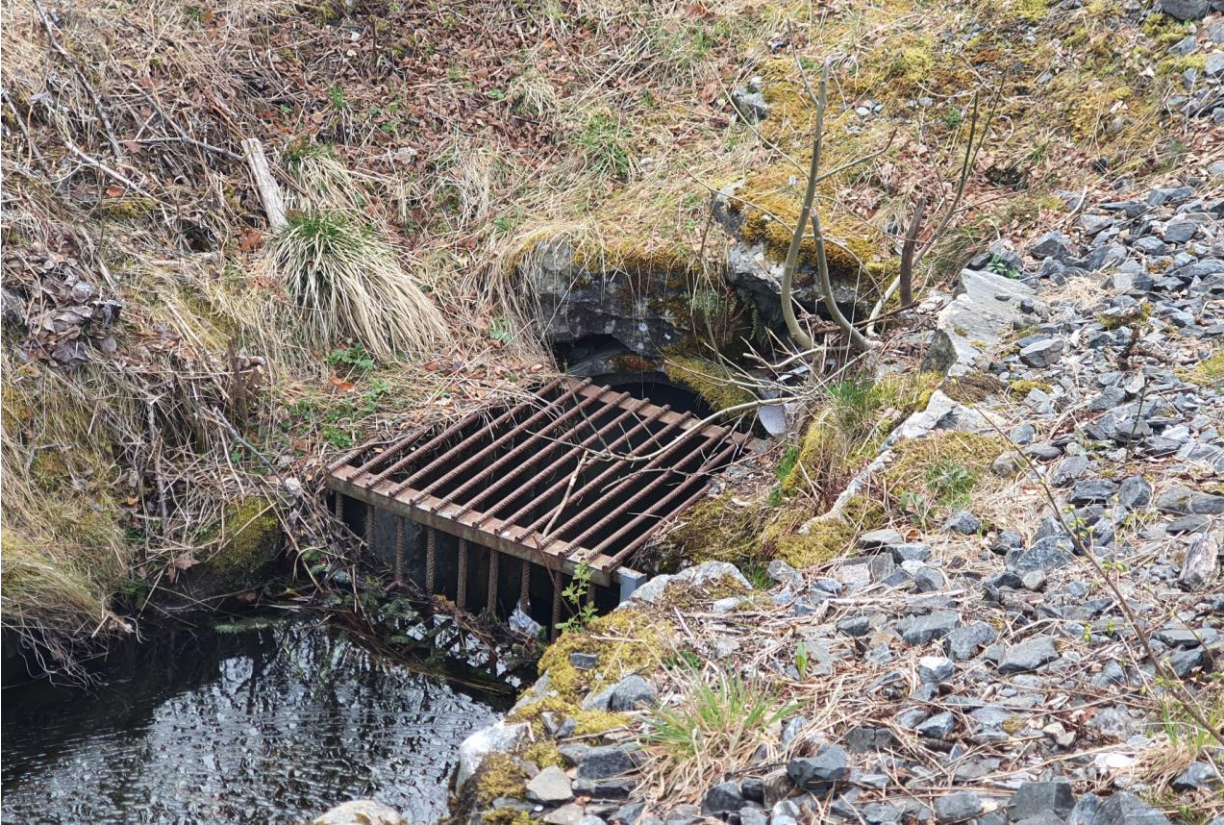
Figur 19: Observert stikkrenne/rist tilknyttet «Kattagrova».
