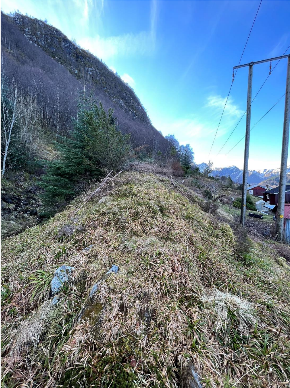
Figur 13. Steinsprangvullen ovenfor bebyggelsen gnr/bnr 72/15, 72/11 og 72/12.
