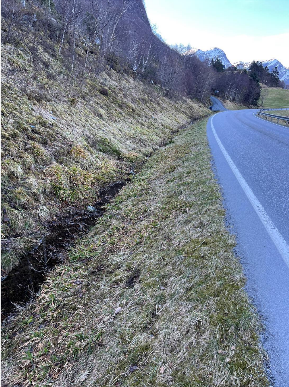
Figur 15. Bred grøft mellom veien og urkanten. Bilde tatt mot sør.
