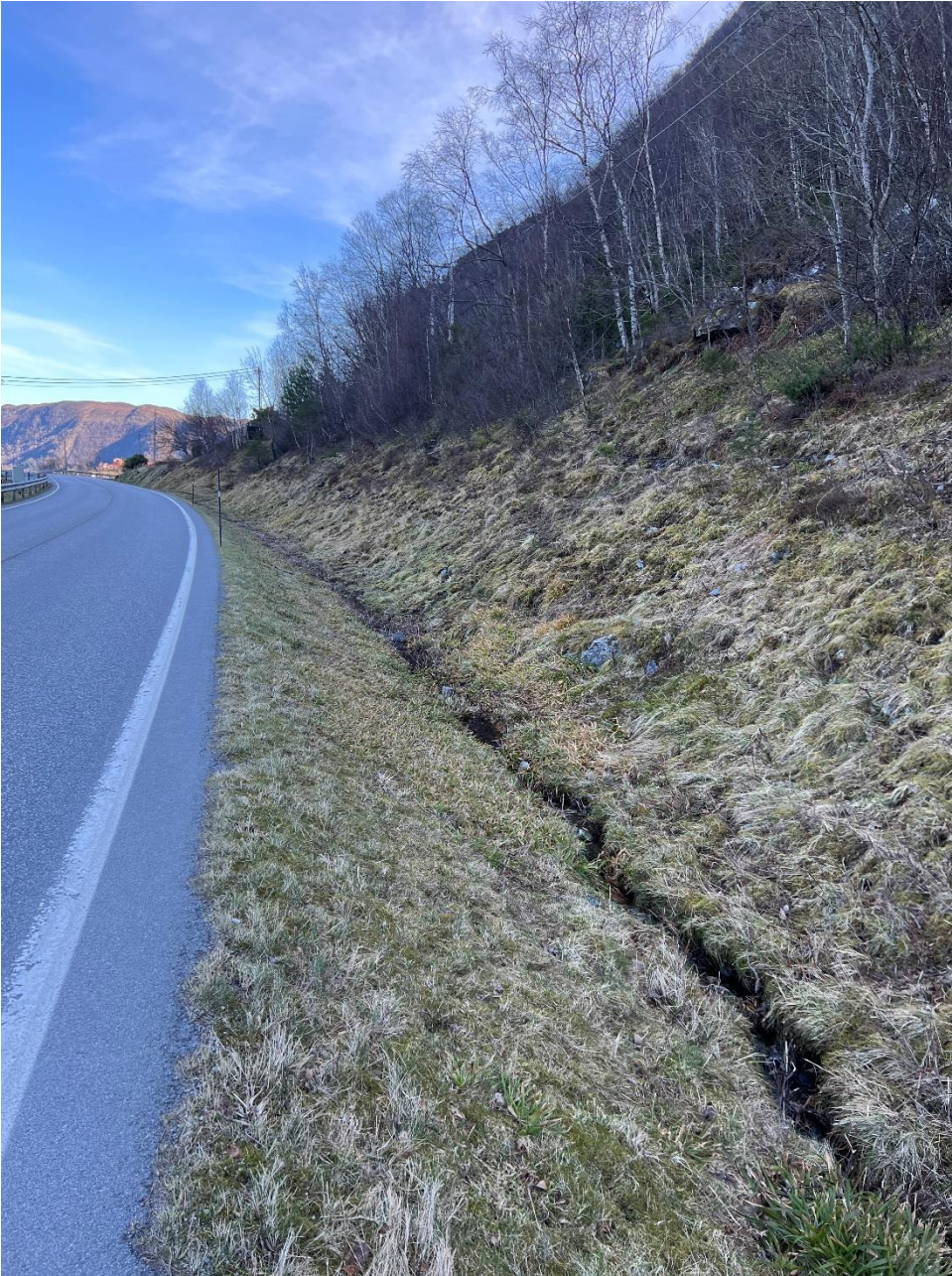
Figur 16. Bred grøft mellom veien og urkanten. Bilde tatt mot nord.
