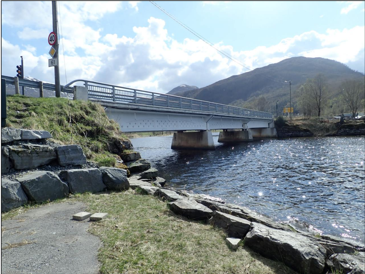
Figur 8: Åheim bru fra nedstrøms side (bilde hentet fra Statens vegvesen sin database Brutus)
