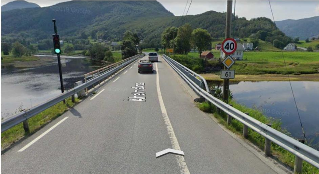
Figur 24: Brua over Åheimselva.
