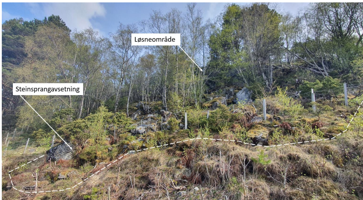
Figur 15: Observert mindre steinsprangavsetning ved kote 75, rett ovenfor eksisterende boligområde ved
