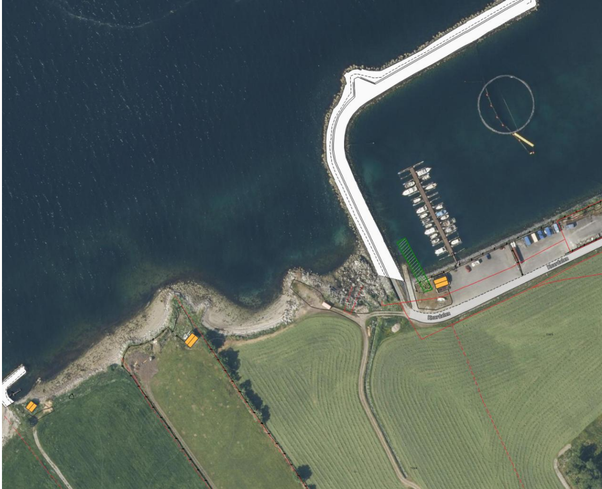
Bilde 2: Flyfoto over område (dagens situasjon).
