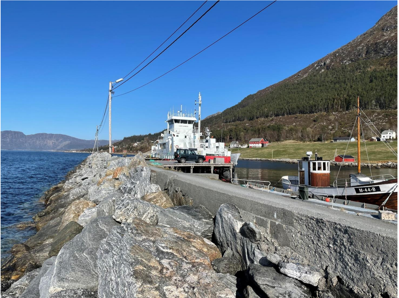
Figur 12 Foto 3 tatt molens langside mot sjøen. Blokkene er lagt i en plastring og dekklaget later til å være intakt.
