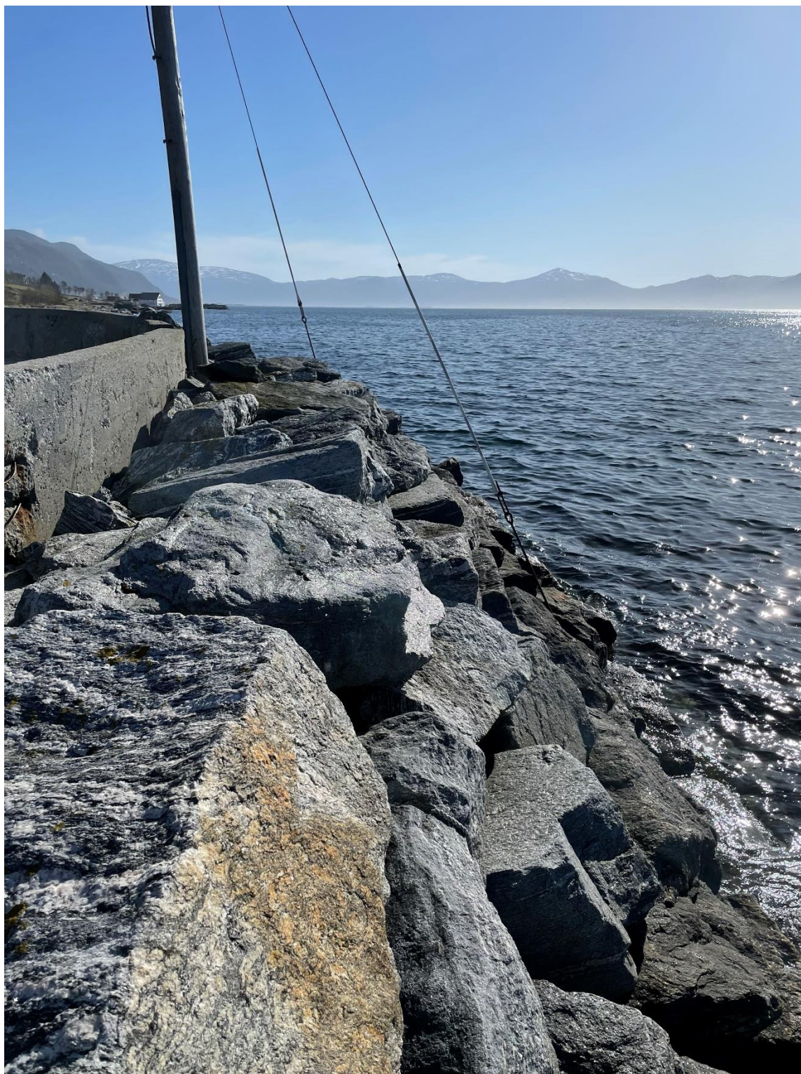
Figur 11 Foto 2 av moloens langside mot sjøen tatt ved svingen. Her er blokkene mer ensgradert sammenliknet med kortsiden og lagt i en plastring.
