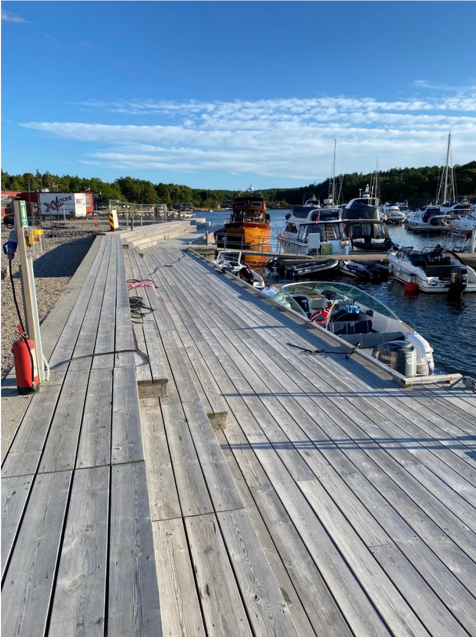
Figur 16 Eksempel på nedsenket brygge med vertikal sjøfront ved Edholmen. Fyllingen (til venstre) ligger på flomsikkert nivå mens bryggen kan oversvømmes under stormflo. Foto: Norconsult
