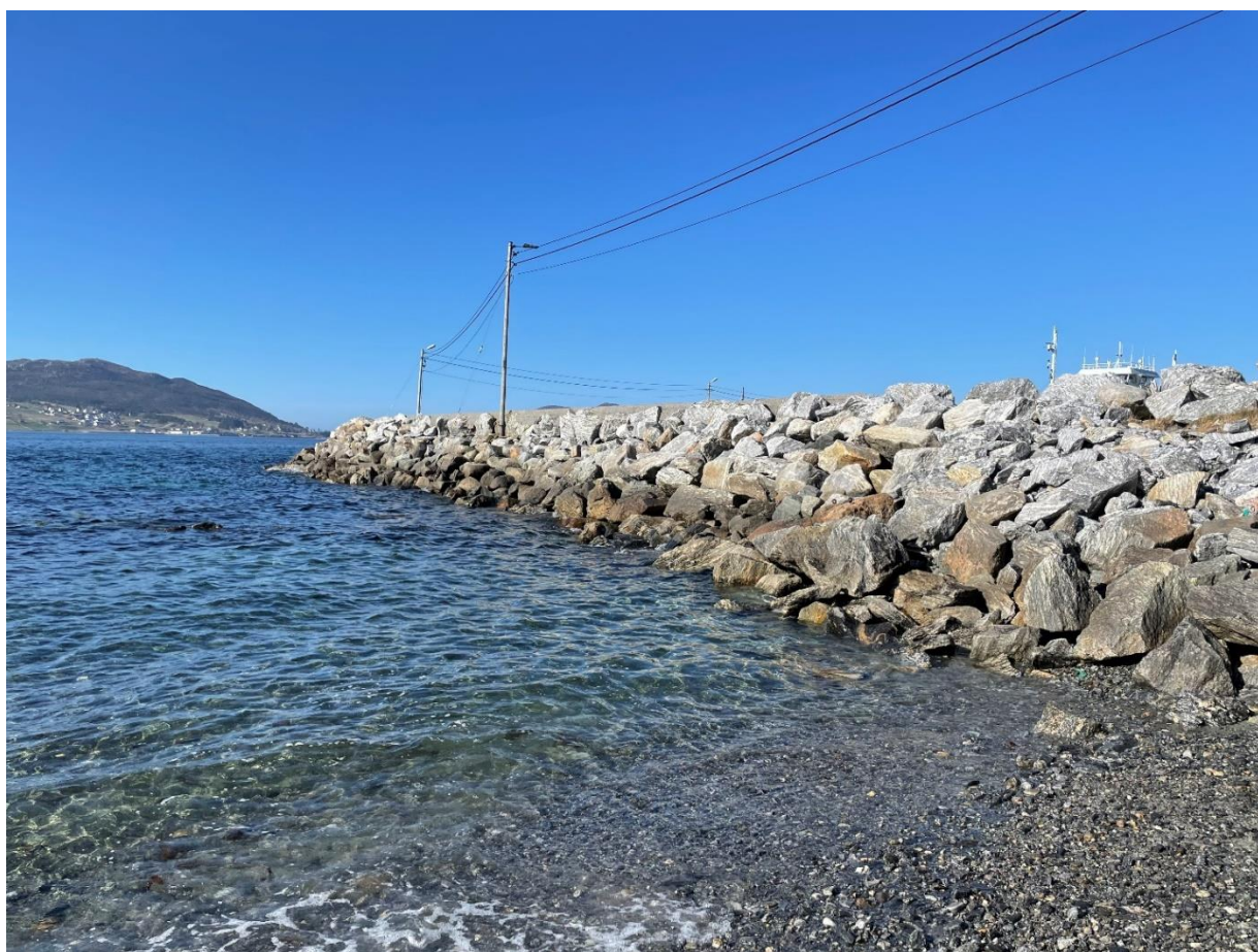
Figur 10 Foto 1 av moloens kortsida ut fra land mot sjøen. Blokkene er lagt ut som en ordnet raus med et stort spekter av blokkstørrelser. Dekklaget later til å være intakt uten store skader.
